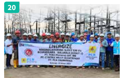
Reconducting Sutet 500 KV Bojanegara-Balaraja bersama PT PLN (Persero) Unit Induk Pembangunan Jawa Bagian Barat dan PT Citra Multi Elektrindo.
